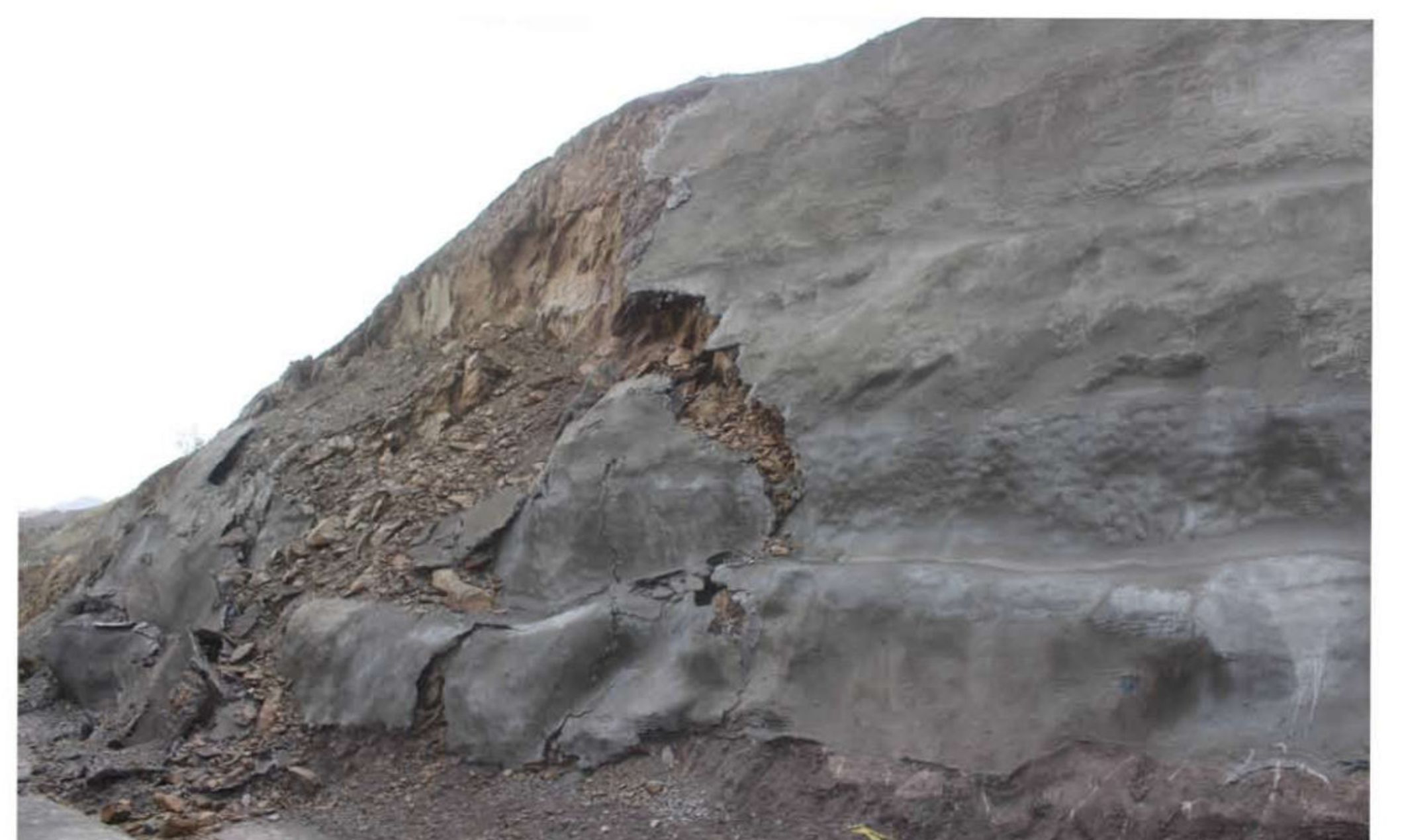
شکل ۲: ریزش ترانشه
